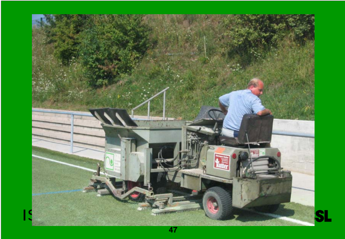
Besanden eines neuen Kunststoffrasenbelages mit Spezialmaschine
